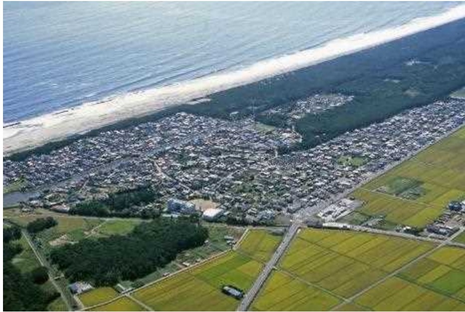
荒浜小学校南西
