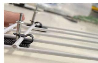
ネットに下にクサビを挟むことで水路壁面に対し傾けてネットを設置
